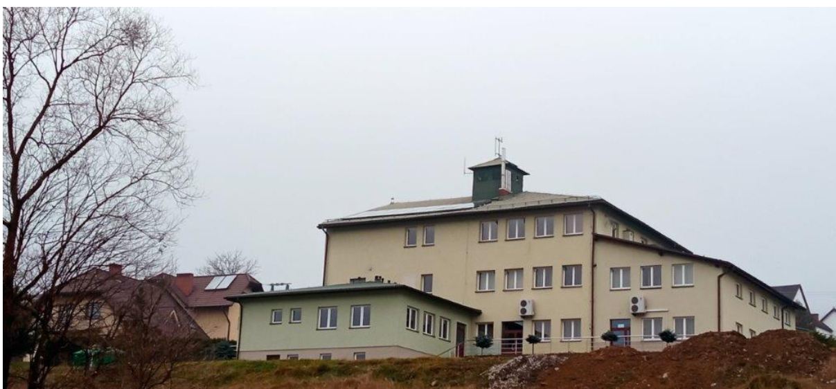
Zdjęcie nr 5 Montaż paneli fotowoltaicznych na budynku OSP w Bieńkówce
