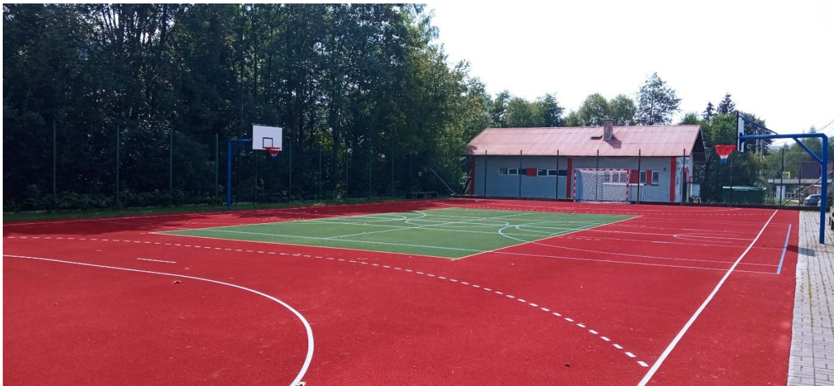
Zdjęcie nr 4 Przebudowa boiska sportowego w miejscowości Palcza
