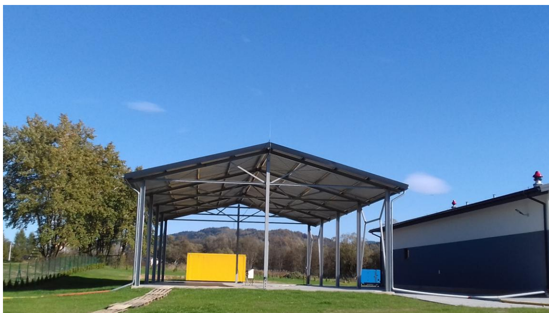
Zdjęcie nr 6 Oczyszczalnia ścieków w Budzowie
