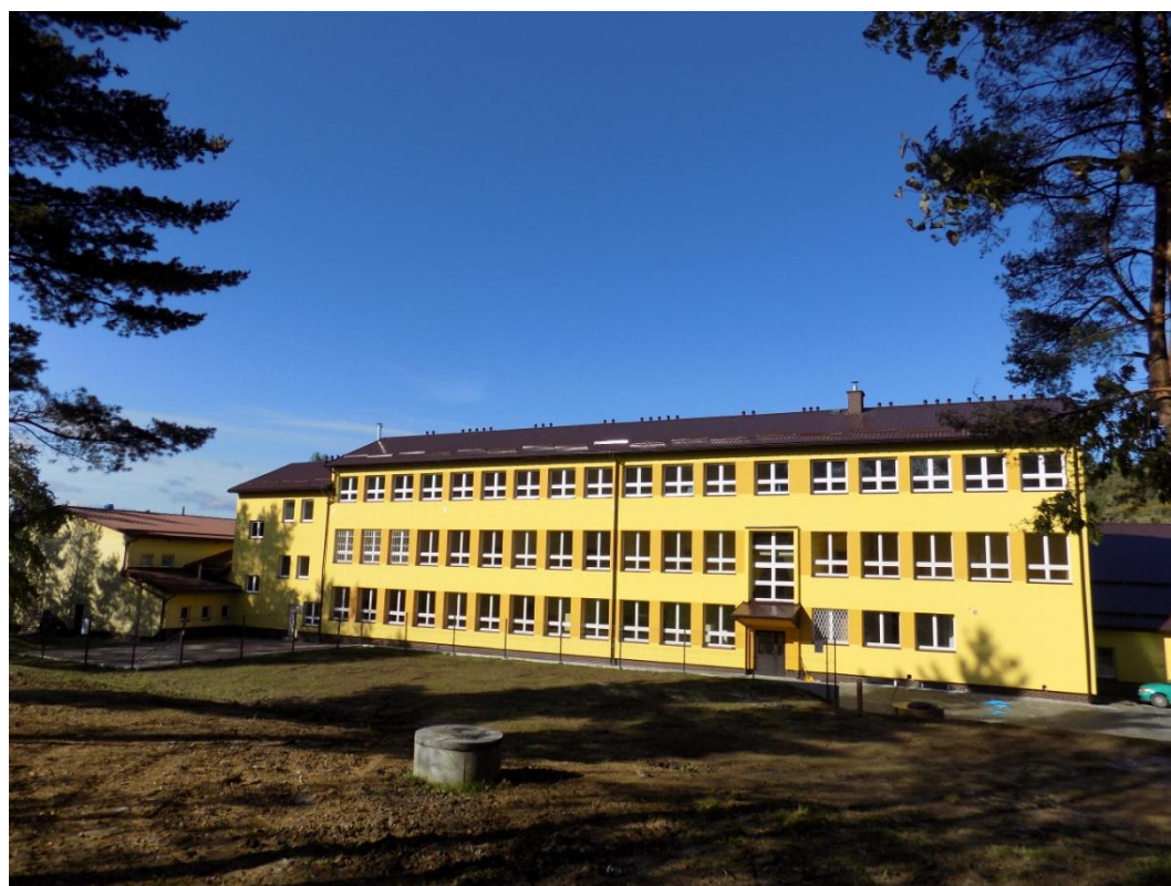
Zdjęcie nr 7 Nadbudowana szkoła w Bienkówce
